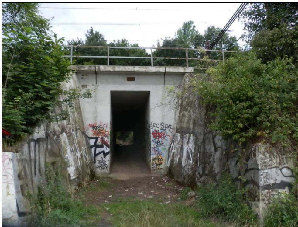
Obr. č. 1 - pohled na objekt zprava. V rámci kompletní rekonstrukce v roce 2000 byla v celém objektu instalována nová nosná desková ŽB konstrukce, bylo injektováno podzákladí, upravena podlaha a sanováno zdivo opěr.
