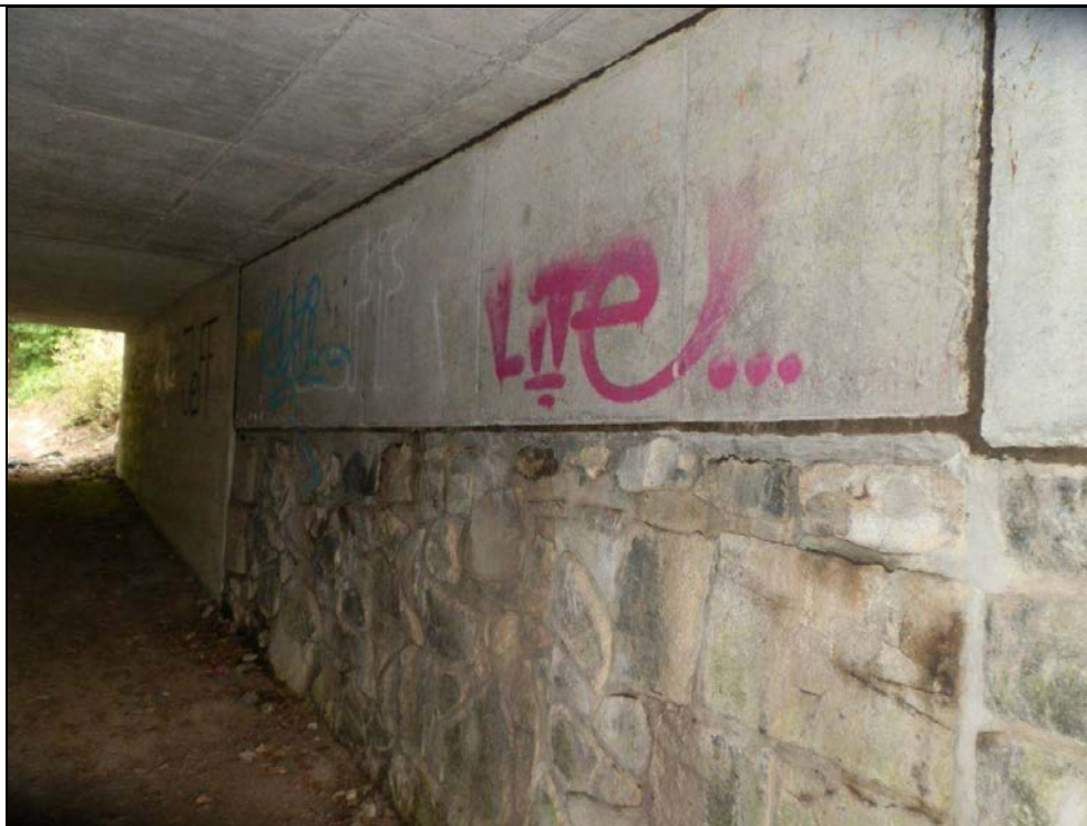
Obr. č. 5 - pohled na levou část opěry Plzeň zprostřed objektu. Zdivo je bez poruch.
