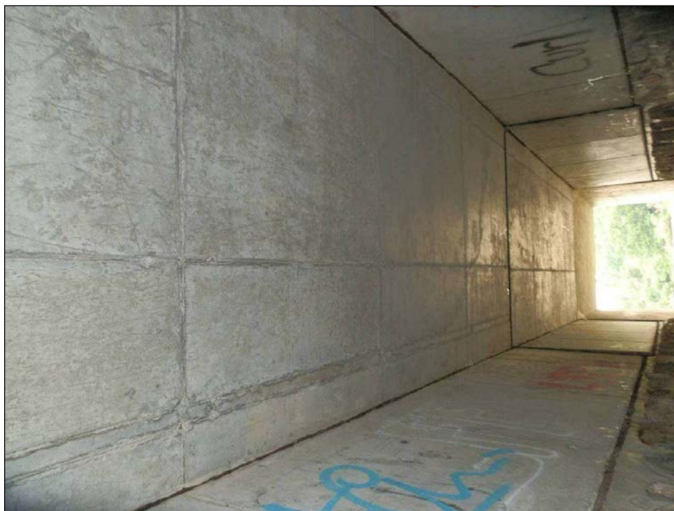
Obr. č. 6 - pohled na nosnou konstrukci. Beton je hladký, suchý, bez záteků a bez poruch
